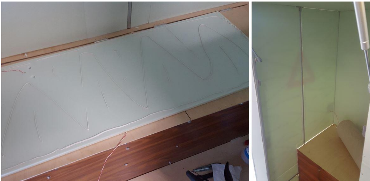
Abb. 56: Verkleben der Styrodurplatten (links) sowie verklebte Styrodurplatte (rechts)
