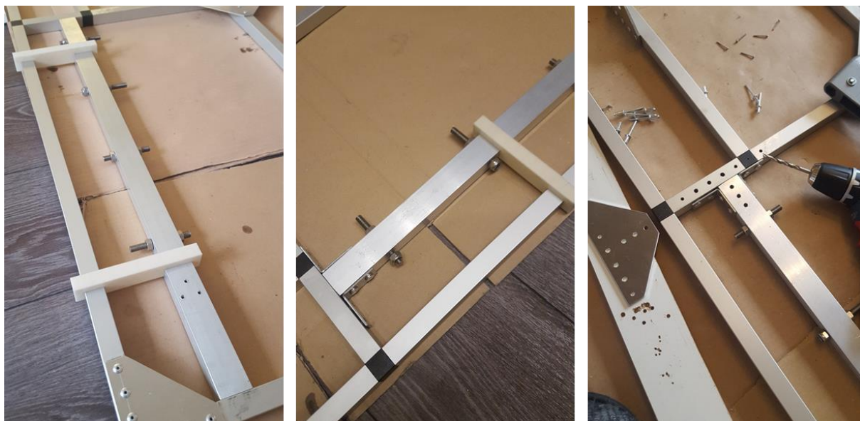
Abb. 11: Einbau der anhängerseitigen Deichselhalterung mit Hilfe von 3D-Druck Ausrichtungshilfen (links) und Verstärkungsblechen (rechts)
