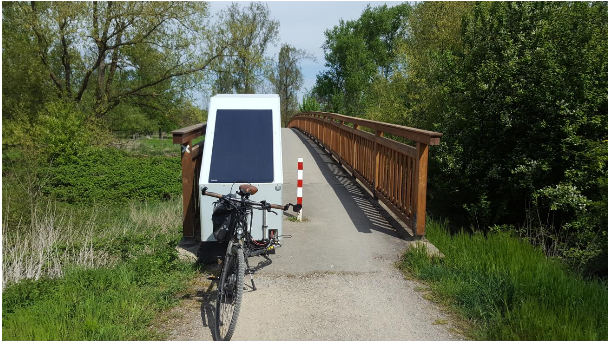
Abb. 77: Die meisten Engstellen sind kein Problem. Sogar die viel engeren Rur-Fahrradbrücken mit nur ca. 90 cm Breite können noch befahren werden!
