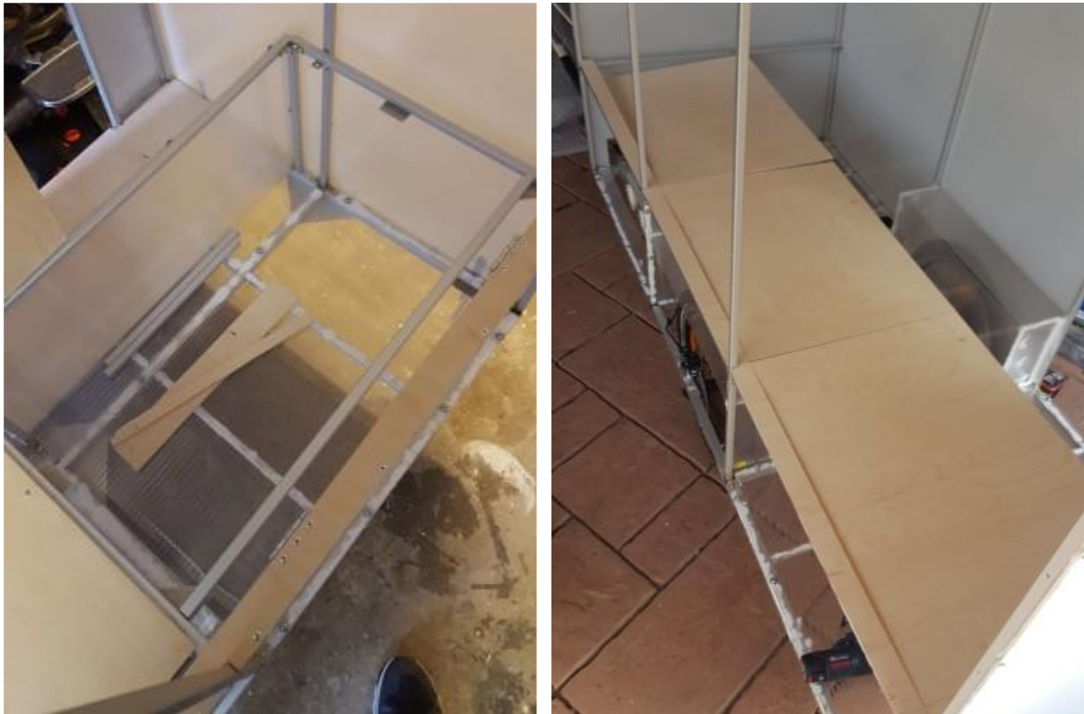
Abb. 42: Anfertigen der Liegefläche aus 4 mm Multiplexplatten
