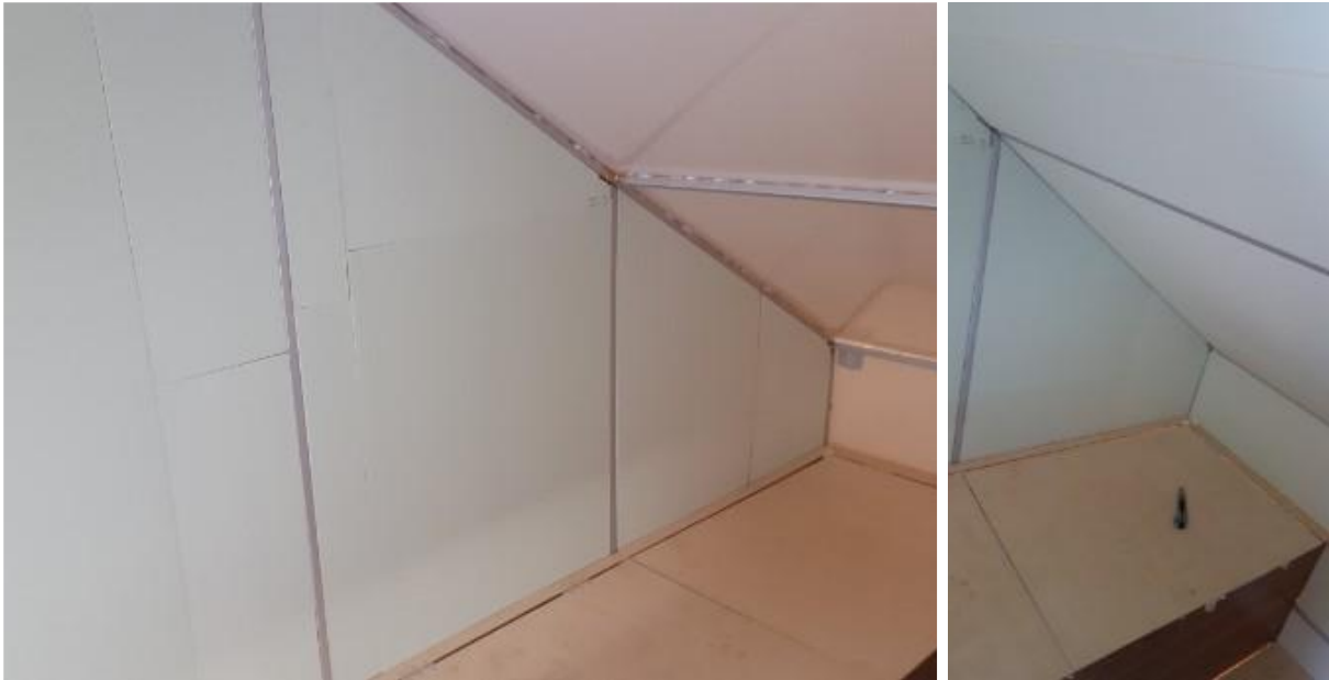
Abb. 55: Dämmung des Innenraums mit Styrodur
