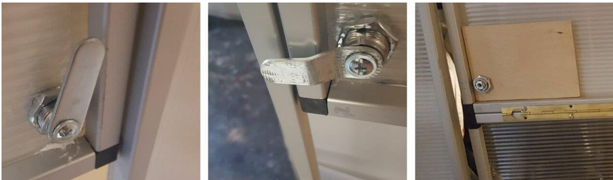
Abb. 47: Einbau der Briefkastenschlösser
