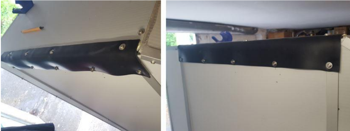
Abb. 48: Türdichtungsgummi
