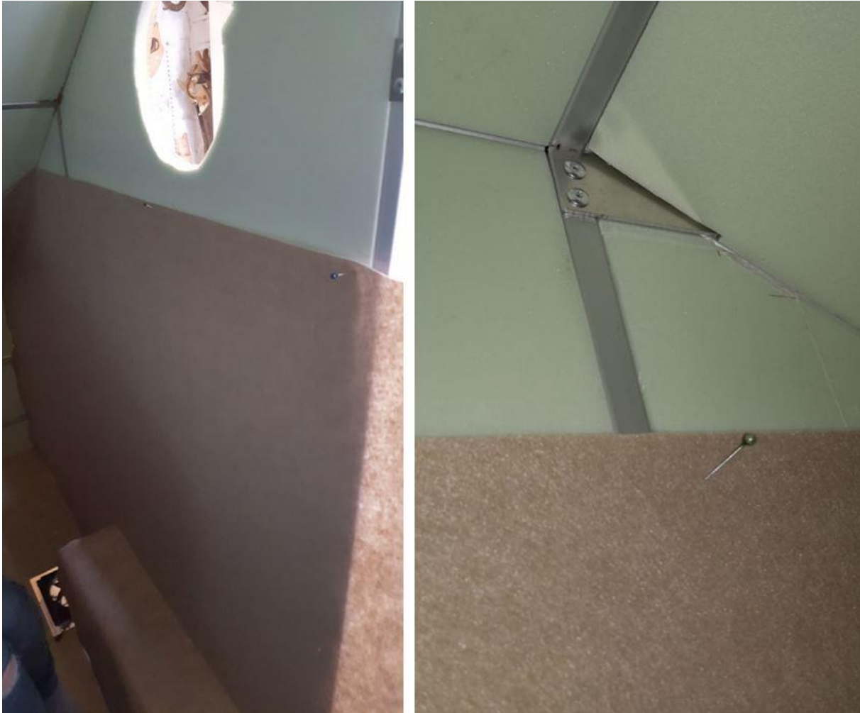
Abb. 57: Anbringung des Filzes mit Hilfe von Stecknadeln
